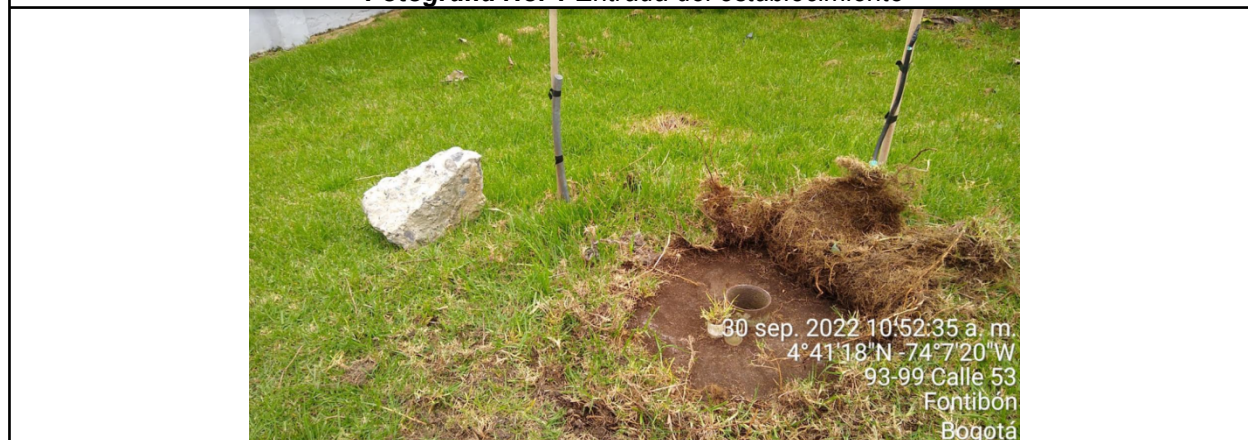
Fotografía No. 2 Pozo objeto de visita técnica
